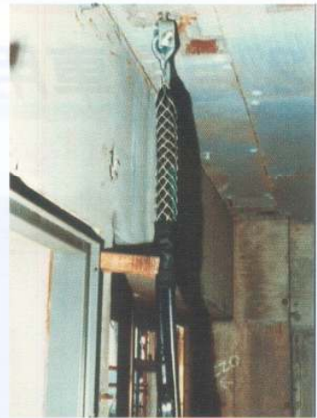
ビル用ケーブルの吊り下げ部(NPE)
